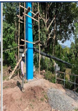
Foto N° 06: Supervisor verifica montaje de tubería HDPE DN 315 mm en pase aéreo.
