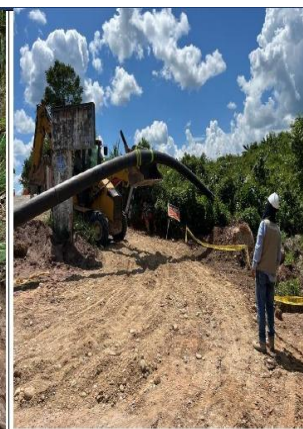
Foto N° 10: Supervisor constata suministro e instalación de tubería HDPE DN 315mm en salida de PTAP.
