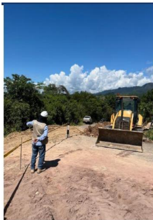
Foto N° 05: Supervisor constata excavacion de zanja c/retro 70KW/94HP A=0.80m, H=3.50 m, TN.
