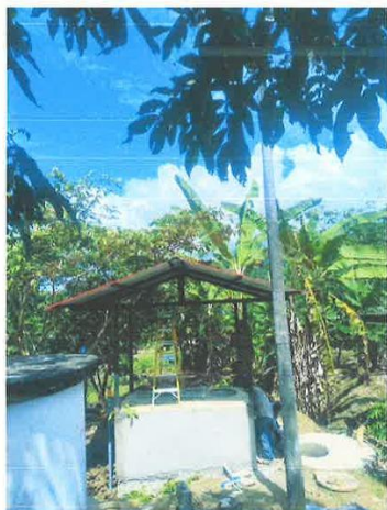
01.04.01.04. CONSTRUICION DE CASETA DE MACROMEDICION EN LA LINEA DE CONDUCCION P/SALIDA R850 M3
