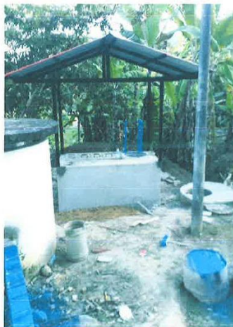
01.04.01.04. CONSTRUICION DE CASETA DE MACROMEDICION EN LA LINEA DE CONDUCCION P/SALIDA R850 M3
