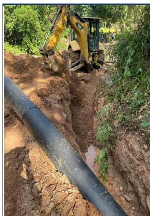
Foto N° 09: Excavación de zanja c/Retro A=0.80m, H=1.40m TN en progresiva 0+960 en línea de aducción.
